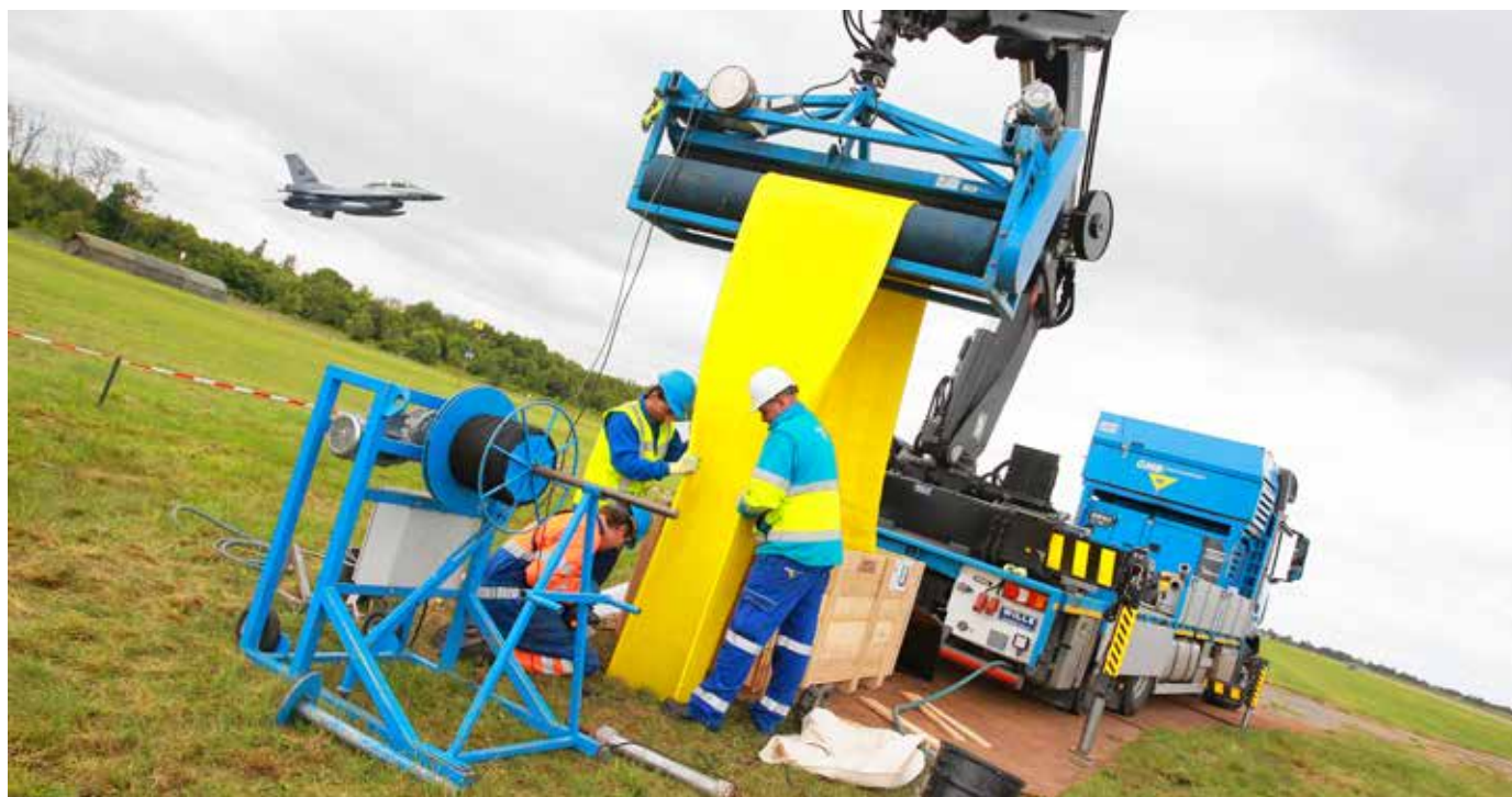
Bij het herstel van de riolering op Vliegbasis Deelen is een no-dig-oplossing toegepast.
