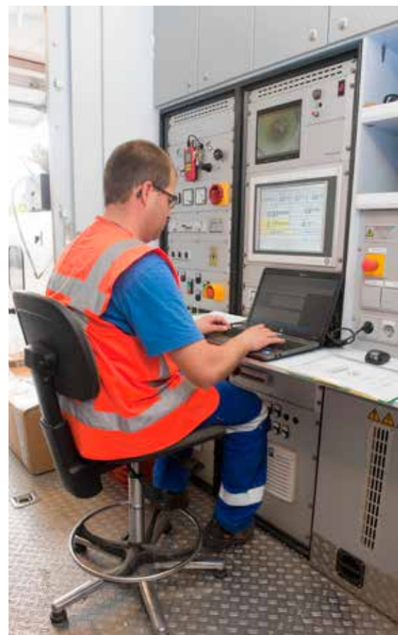
Via een monitor wordt gevolgd wat de temperatuur van de binnenzijde van de kous is, wat de luchtdruk in de kous is en met welke snelheid de lichttrein door het riool gaat.
