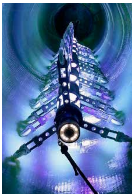
De lichttrein zorgt voor uitharding. Om te voorkomen dat later styreen uitlooft, is gekozen voor een styreenvrije kous.
